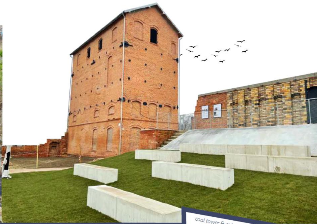
wieża węglowa i bateria koksownicza 2020
